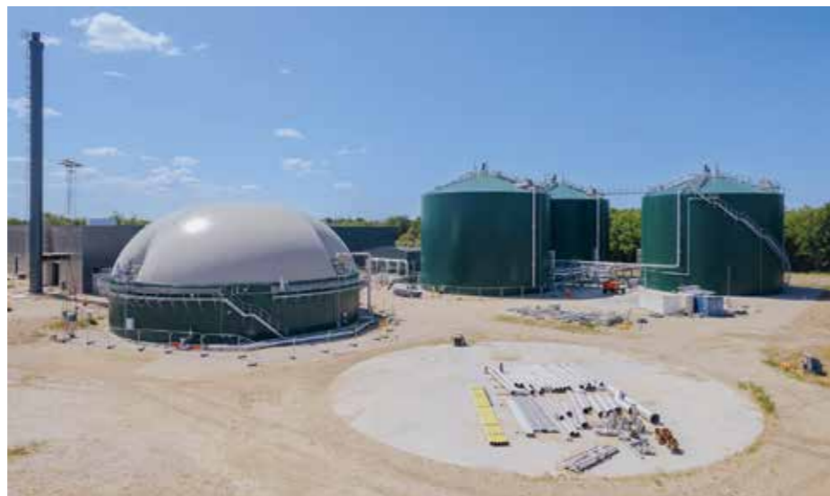
Tanskassa rakenteilla oleva biokaasulaitos.
